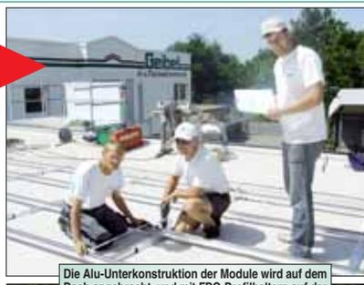
Die Alu-Unterkonstruktion der Module wird auf dem Dach angebracht, und mit FPO-Profilhaltern auf der Dachhaut verschweißt. Eine zusätzliche Aufstärkung durch Betonplatten oder Kies ist nicht notwendig.
