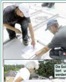
Die Solarmodule werden montiert und durch die Kanäle werden die Kabel gezogen,....
