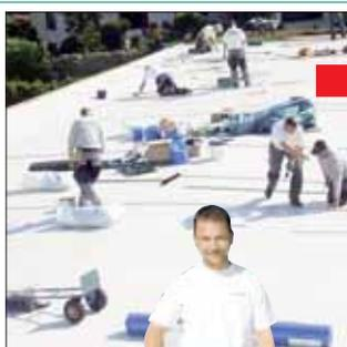
Zuerst wurde auf dem Flachdach eine neu- und hochwertige FPO-Abdichtung im Heißluftschweißverfahren verlegt und mechanisch in der Tragkonstruktion befestigt.
